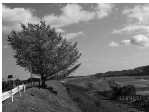
写真-2 上流から見た現在の万代堤
