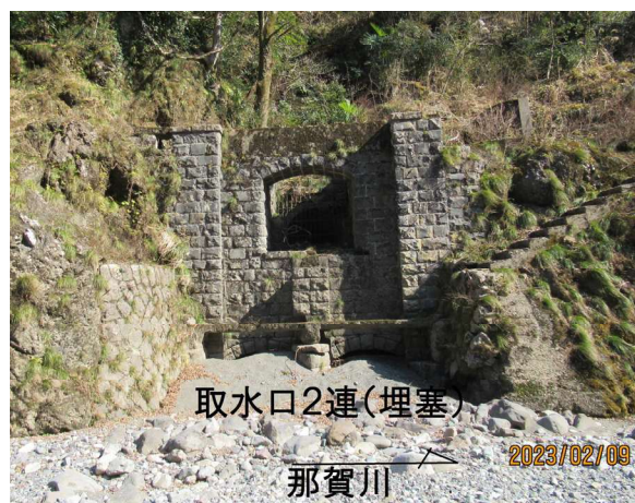
写真－ 6 現在の発電取水口跡
