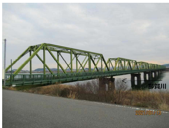
写真－ 10 J R 牟岐線那賀川橋梁
