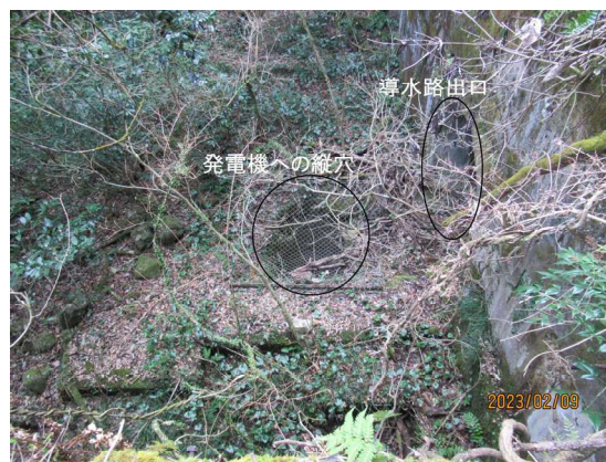
写真－ 4 導水路出口と発電機への縦坑
