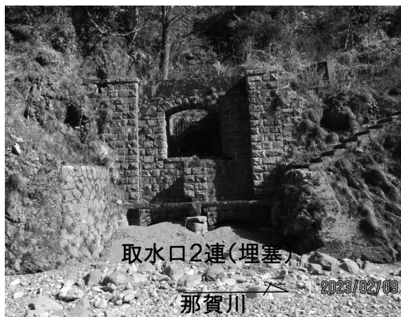
写真－6 現在の発電取水口跡
