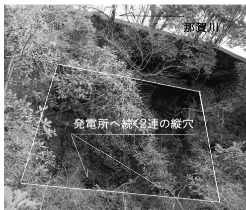
写真－3 発電機へ続く2連の縦穴
