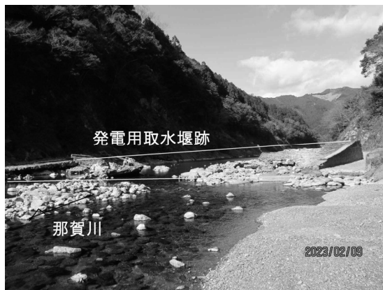
写真－ 7 発電取水堰の跡
