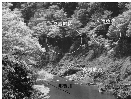
写真－2 現在の桜谷発電所跡と放流口
