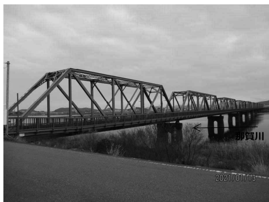
写真－ 10 J R 牟岐線那賀川橋梁
