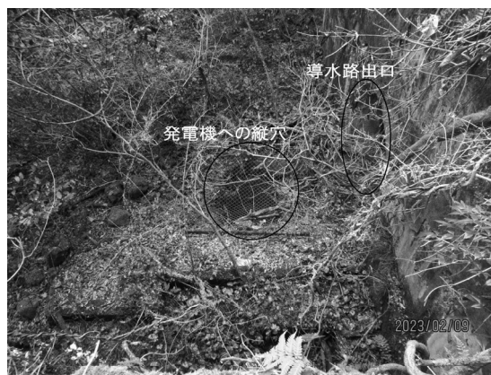
写真－4 導水路出口と発電機への縦穴
