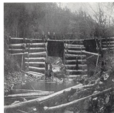
図 7 古屋川上流の鉄砲堰 23)
