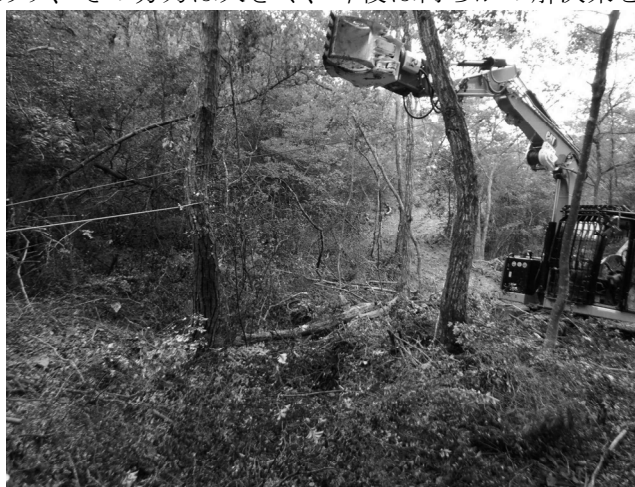
写真4 フェラバンチャーザウルスによる集材
