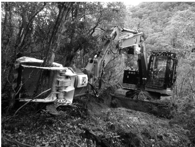
写真1 フェラバンチャーザウルスによる作業
