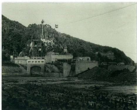
写真-8 工事中の北岸用水堰 (下方に見える杭が下広瀬堰)
