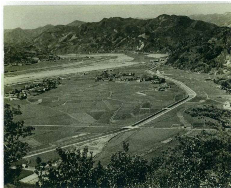
写真-9 完成した北岸用水路 (広瀬用水を拡幅し幹線水路とした)
