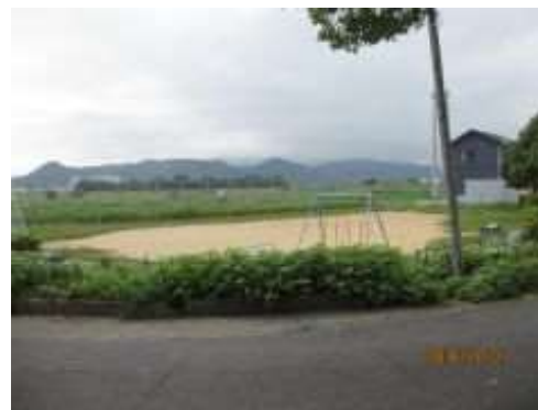
写真-3 左と同じ位置から見た現在の取水口跡 (埋立てられ堤防と公園になっている)
