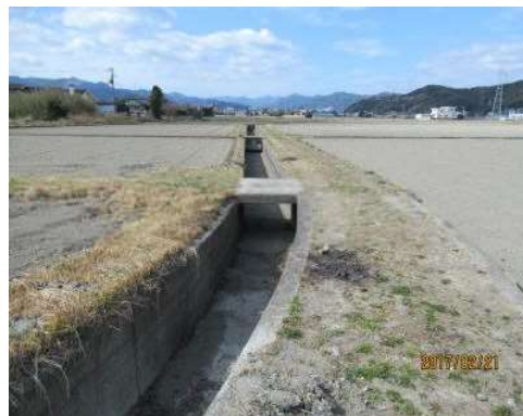
写真-5 現在も使われている下広瀬用水
