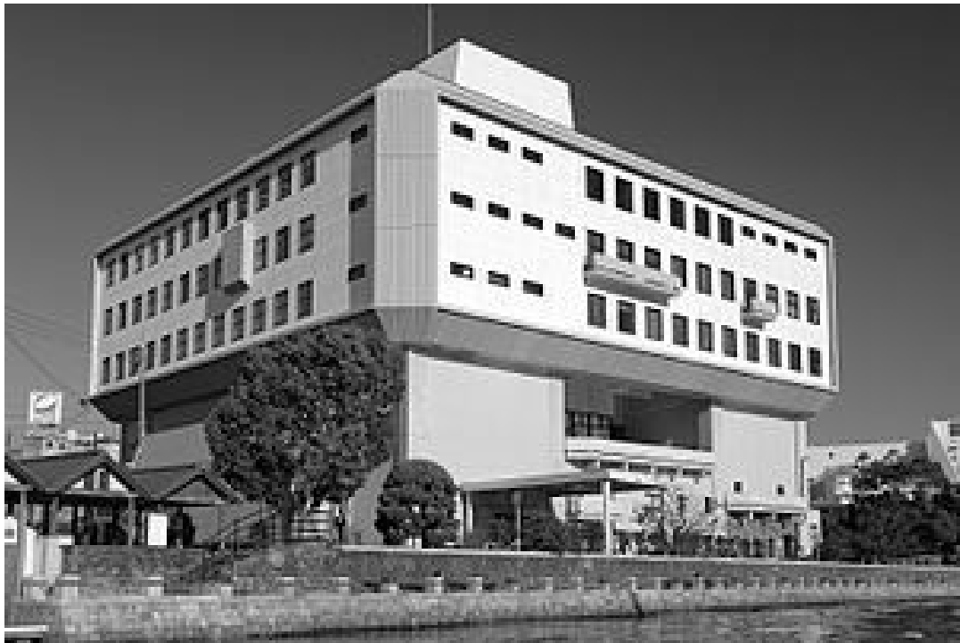
写真-3 徳島県郷土文化会館
