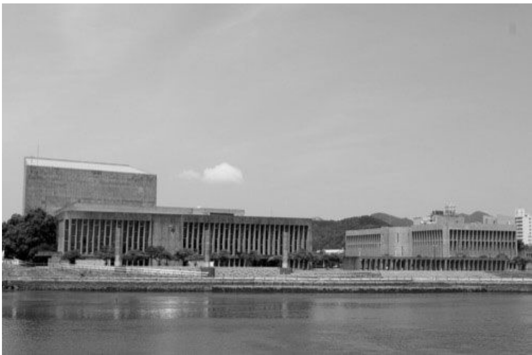
写真-4 鳴門市文化会館
