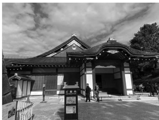
写真-22 本丸御殿（平成 30 年復元工事完成）
