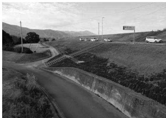
写真－ 20 江川大堰のあった箇所の堤防
