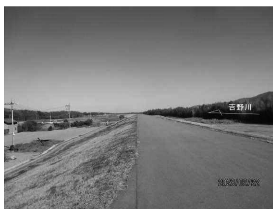
写真- 11 吉野川本川堤防（旧堤を拡幅・嵩上）
