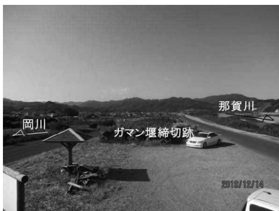
写真－ 21 ガマン堰があった箇所の堤防
