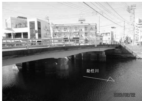
写真－23 3 代目助任橋(現在工事中)
