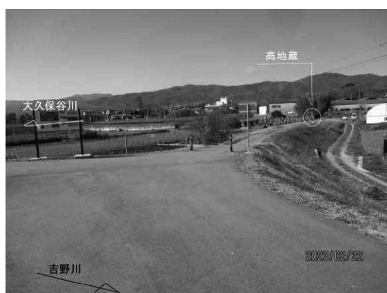
写真- 10 伊沢市堤（大久保谷川左岸区間）
