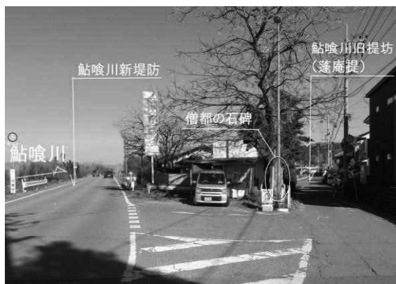
写真－ 8 鮎喰川の新堤防と旧堤防（僧都）
