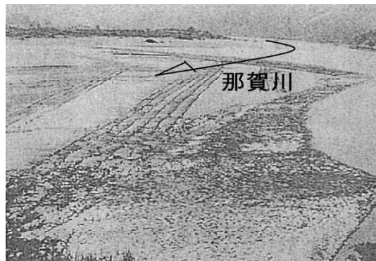
写真－18 下広瀬堰
